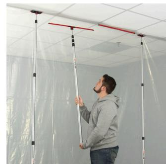
Pour fixer les bandes magnétiques, montez l'applicateur fourni sur n'importe quel poteau ZipWall®. Placez chaque bande sur l'applicateur et soulevez-la au plafond en utilisant le poteau comme poignée. Les aimants puissants se fixeront sur le cadre, tenant fermement la barrière contre le plafond et vous permettant de retirer facilement l'applicateur.
